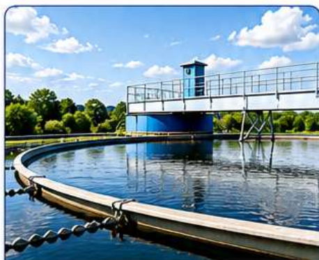
01. Stations de traitement des eaux usées
